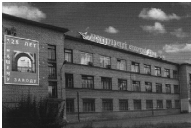
Ленинградский Северный завод. Фотография 1971 года
